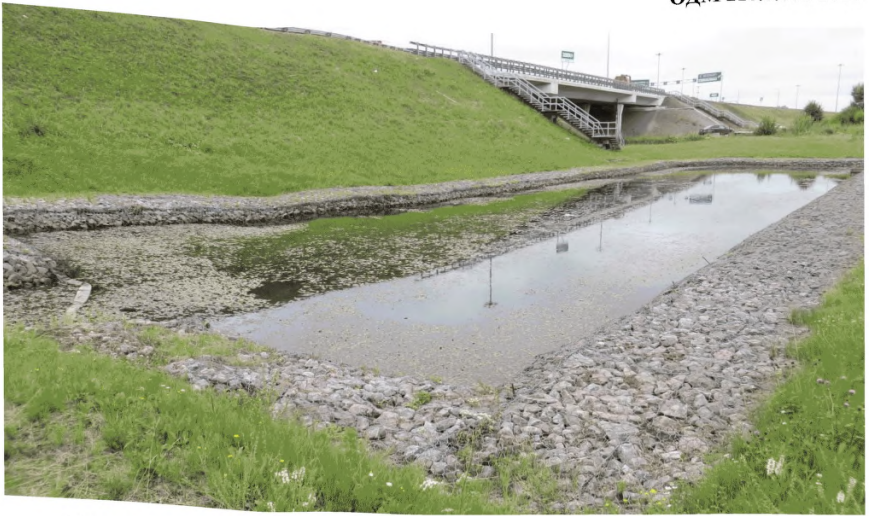
Рисунок 11 – ГБП с устройством плавающих бонов из сорбирующего нефтепродукты материала
