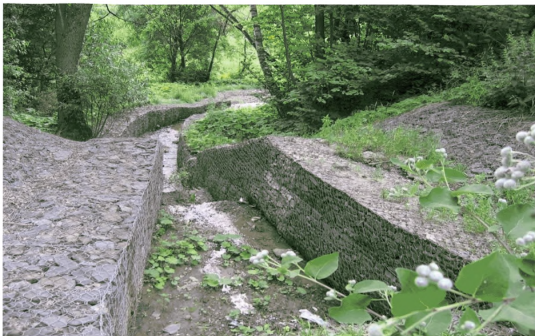
Рисунок 36 - Лоток сброса очищенных стоков на рельеф местности, выполненный с использованием габионов
