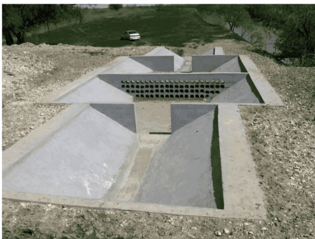
Рисунок 33 – Простейшее очистное сооружение с отстойником и щебёночной загрузкой
