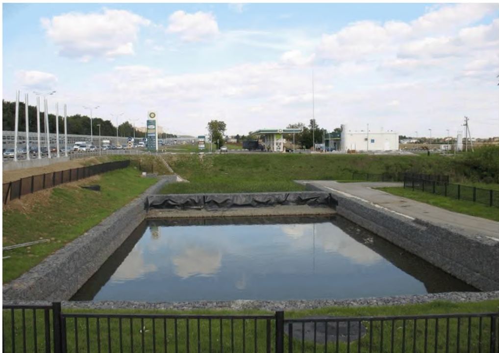
Рисунок 6 - Пруд-отстойник каскадного типа с использованием габионов
