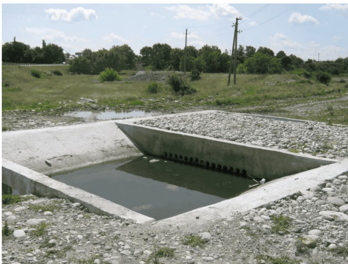
Рисунок 34 – Простейшее очистное сооружение с отстойником и щебёночной загрузкой (вид сбоку)
