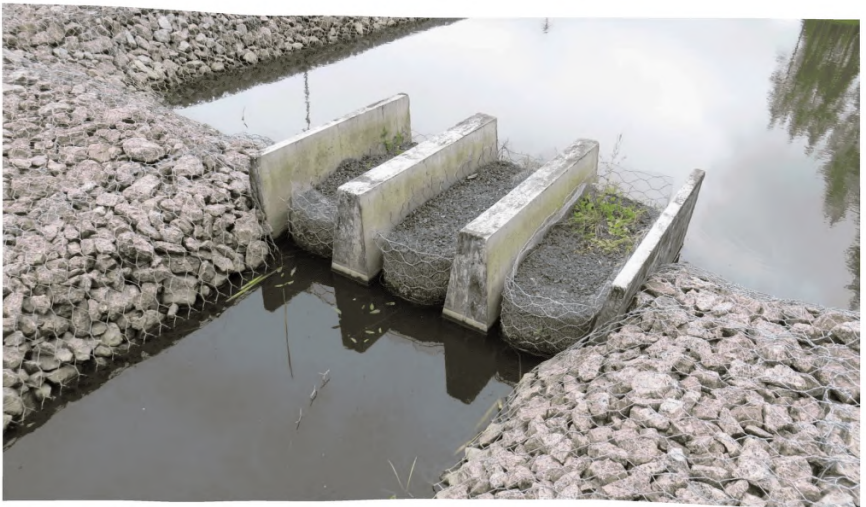
Рисунок 12 – Фильтрующая кассета с загрузкой природным сорбентом
