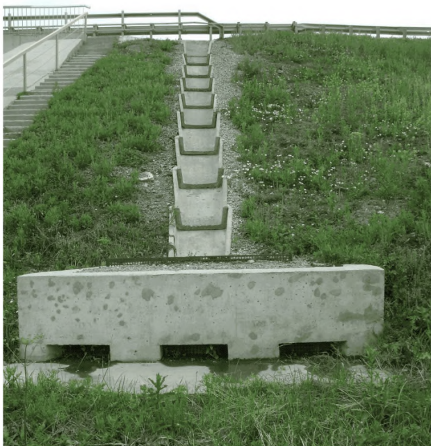
Рисунок 30 – Простейшие очистные сооружения со щебёночной загрузкой
