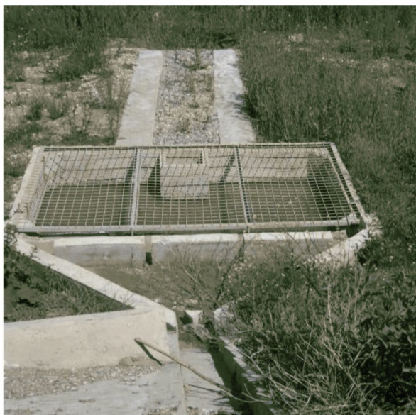
Рисунок 32 – Простейшее очистное сооружение с отстойником и щебёночной загрузкой (вид сверху)
