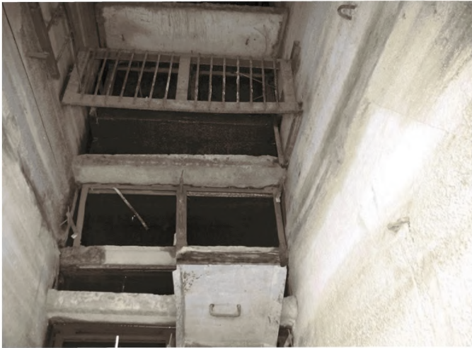
Рисунок 25 - Очистное сооружение индивидуального проектирования кассетного типа (секция очистки ливневых сточных вод)
