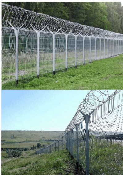
Рис. 1.3. - Основное ограждение из ССЦП усиленное верхним спиральным барьером безопасности.
