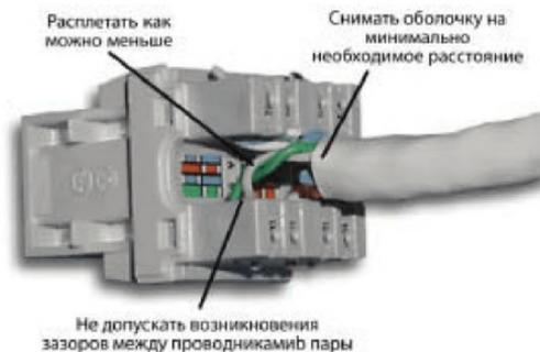
Рисунок 8. Пример правильно выполненного монтажа: пары расплетены на минимальное расстояние, необходимое для заделки.
