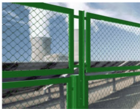
Рис. 2.12. Примеры увеличения высоты основного ограждения посредством использования дополнительного верхнего ограждения
