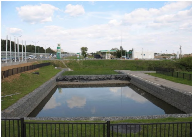
Рисунок 6 – Пруд-отстойник каскадного типа с использованием габионов
