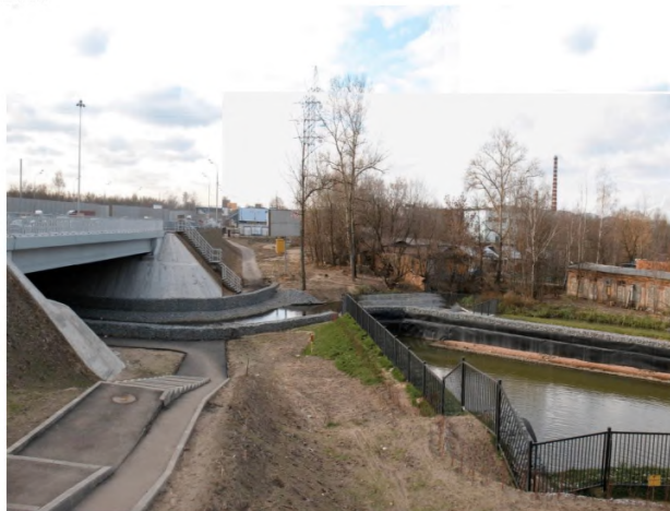
Рисунок 7- Пруд-отстойник с использованием габионов
