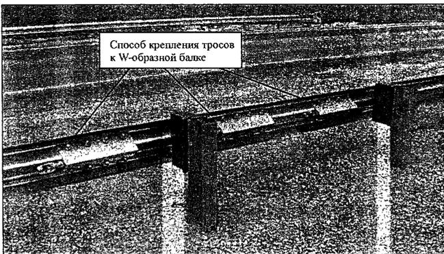
Рисунок 6 – Пример сопряжения профильного ограждения с тросовым
