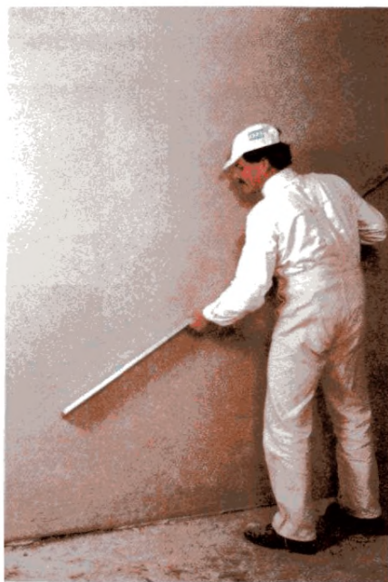
Выравнивание растворной смеси правилом
