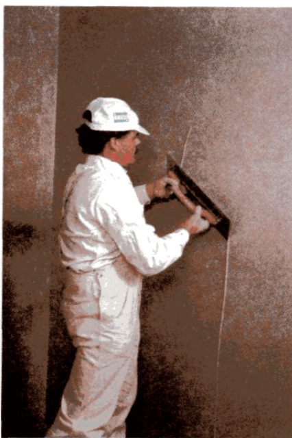
Заглаживание оштукатуренной поверхности
