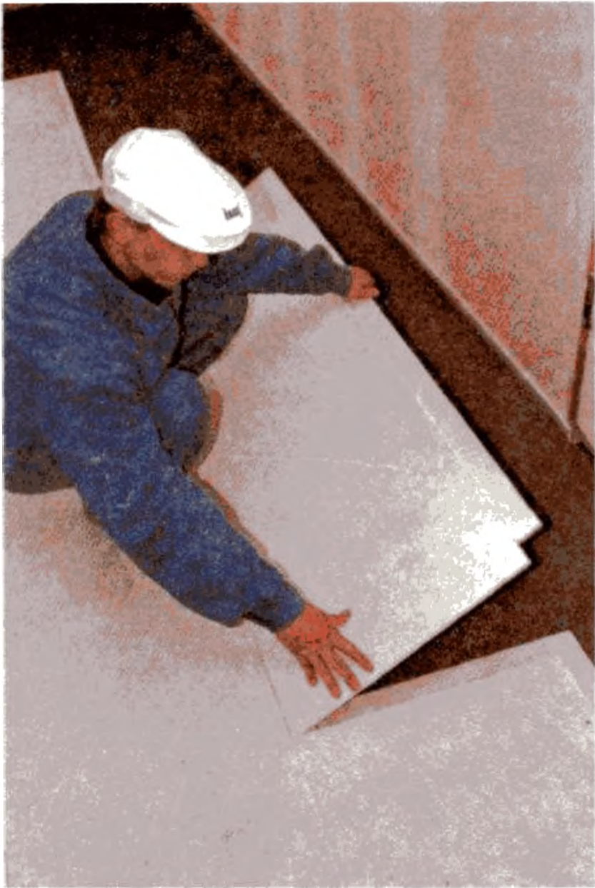
Устройство слоя сухой засыпки по слою пароизоляции
