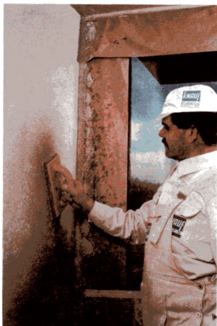
Затирка растворной смеси губчатой теркой
