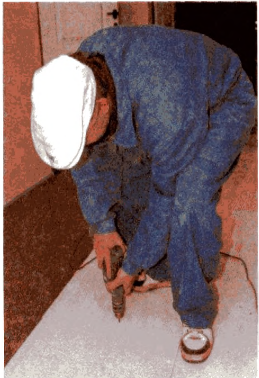
Скрепление элементов пола
