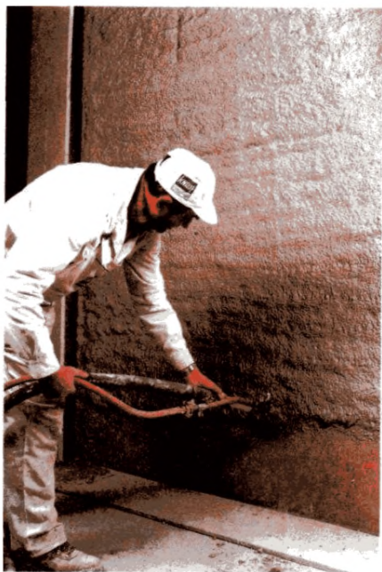
Нанесение гипсовой смеси машинным способом
