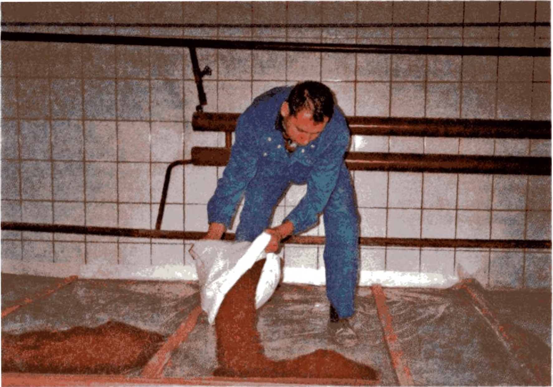
Устройство слоя сухой засыпки по слою пароизоляции
