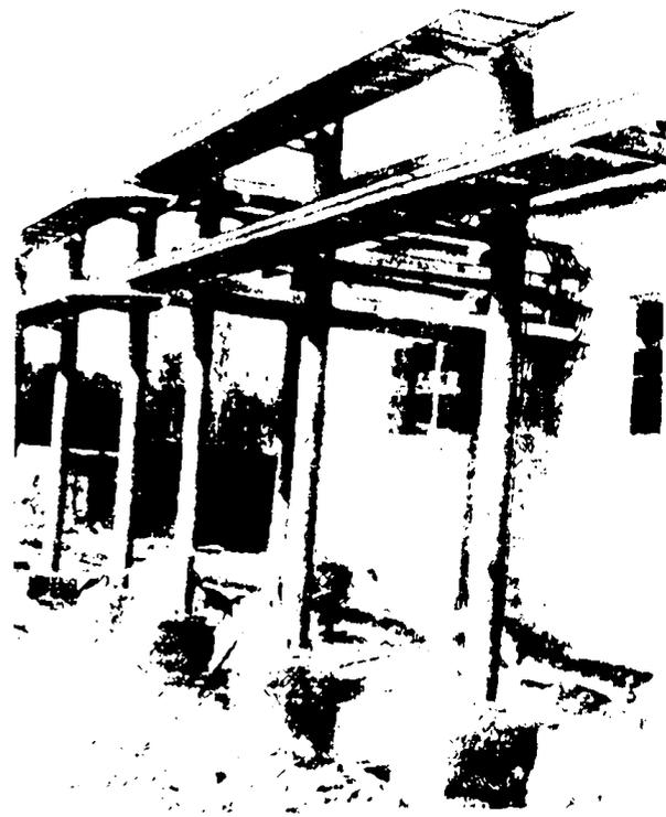
Рис.6. Опорные элементы из монолитного железобетона:
