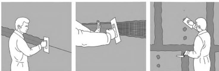
Рис. 17. Шпаклевание стыков и мест установки шурупов.
