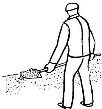
5 РАЗРАВНИВАНИЕ И ПРИКАТКА ГРАВИА; К<sub>1</sub> - 28 мин; К<sub>4</sub> - 38 мин; К<sub>5</sub> - 51 мин; гребки, каток
