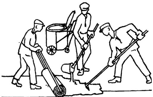
Кровельщик  $K_4$  набирает ковшом из бачка мастику и разливает ее по основанию. Кровельщик  $K_1$  разравнивает гребком разлитую мастику, а кровельщик  $K_2$ , раскатывая рулон, приклеивает полотнище
