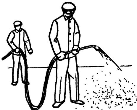
Машинист компрессора открывает вентиль подачи сжатого воздуха в бак с эмульсией и на удочку, а также вентиль подачи эмульсии на удочку. Затем кровельщик К<sub>1</sub> открывает краны подачи воздуха и эмульсии на удочке и регулирует факел распыления. Эмульсию наносят слоем толщиной 0,5-0,6 мм движением удочки на себя, держа сопло удочки на расстоянии 40-60 см от огрунтовываемой поверхности под углом
