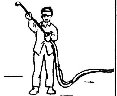
Кровельщик K<sub>1</sub> подсоединяет к одному концу шланга форсунку. Другой конец кровельщик K<sub>2</sub> соединяет с установкой, а затем включает последнюю. Кровельщик K<sub>1</sub> регулирует струю огрунтовочного состава, добиваясь ее равномерности
