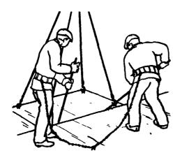
Монтажники  $M_1$  и  $M_2$  принимают поданную краном плиту, подводят ее к месту укладки и укладывают на раствор. Затем монтажник  $M_1$  проверяет правильность укладки плиты, а монтажник  $M_2$  помом рихтует ее в проектное положение
