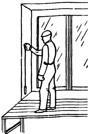
Штукатур берет подготовленный заранее откос, прижимает его к поверхности, покрытой раствором, и подгоняет вплотную к оконной коробке, слегка постукивая по нему киянкой с резиновой набойкой. Правильность установки откоса он проверяет отвесом
