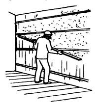
Штукатур Ш с помощью правила разравнивает грунт по маякам до получения ровной поверхности. Штукатур Ш полутерком разравнивает грунт в труднодоступных местах, а затем контрольным правилом проверяет ровность поверхности
