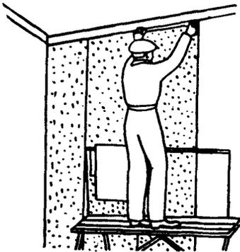
Маляр  $M_1$  берет с перекладины столика-подмостей намазанное клейстером полотнище, разворачивает его и прикладывает верхний край к линии верха обоев. Маляр  $M_2$ , ориентируя полотнище по наметченной линии, приклеивает нижнюю часть полотнища
