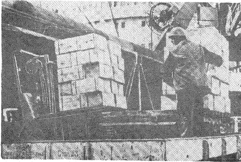
Рис.502.3. Погрузка в вагон фиников в деревянных ящиках погрузчиком с использованием гребенчатого поддона и поворотного круга. Порт Николаев
