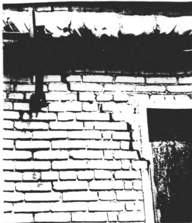
Рис. I2 Наклонная трещина в кирпичной стене по неперевязанному сечению
