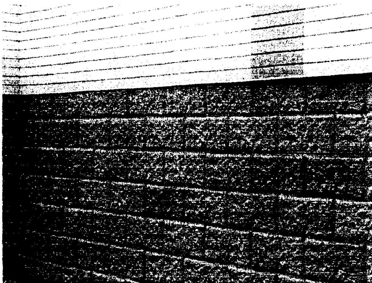
Рис. 3.4. Цоколь здания, облицованный антивандальной системой предприятия ООО «РВМ-2000» с применением бетонной плитки
