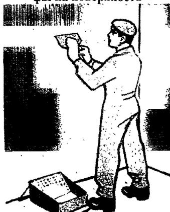
Рисунок 22 – Нанесение шпатлевки на поверхность
