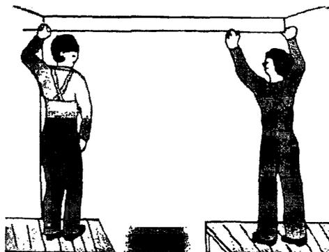
**Рисунок 1 – Разбивка линии верха обоев намеленным шнуром**
