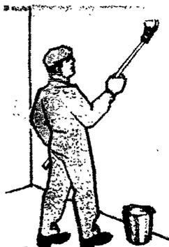
Рисунок 8 – Нанесение клейстера на всю поверхность стены
