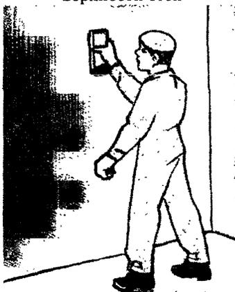
Рисунок 21 – Выравнивание поверхности колодкой со шкуркой
