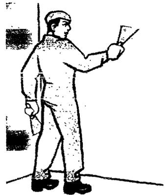
Рисунок 4 – Заполнение шпатлевкой трещины
