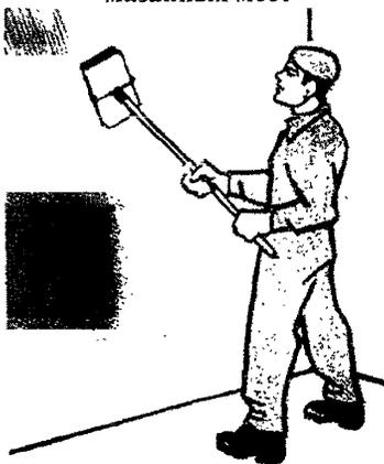
Рисунок 23 – Шлифовка поверхности шарнирными терками
