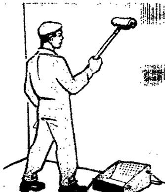
Рисунок 19 – Нанесение олифы на поверхность
