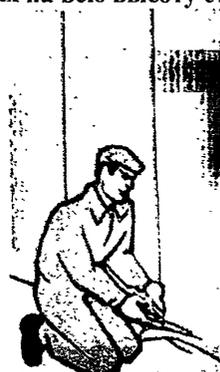
Рисунок 13 – Прирезка наклеенных полотнищ обоев у пола
