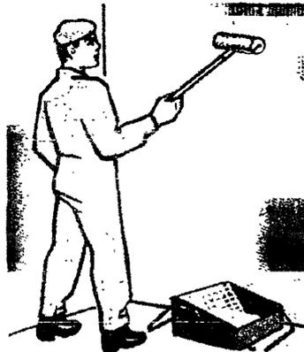
Рисунок 3 – Нанесение грунтовки на поверхность
