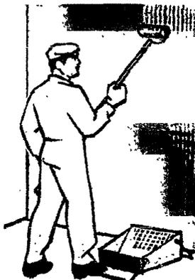
Рисунок 25 – Нанесение клеевого состава на поверхность стены
