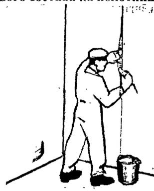
Рисунок 29 – Отгибка и промазка кромок полотнищ
