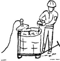
Бетонщики (Б<sub>1</sub>) и (Б<sub>2</sub>) загружают в емкость необходимое количество цемента, песка и воды. Затем бетонщик (Б<sub>1</sub>) включает пневмодрель для перемешивания.
