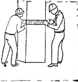
Бетонщики (Б<sub>1</sub>) и (Б<sub>2</sub>) устанавливает пресс-опалубку в проектное положение. Затем заводят в пазы угольников опалубки откидные болты и затягивают их гайками-барашками
