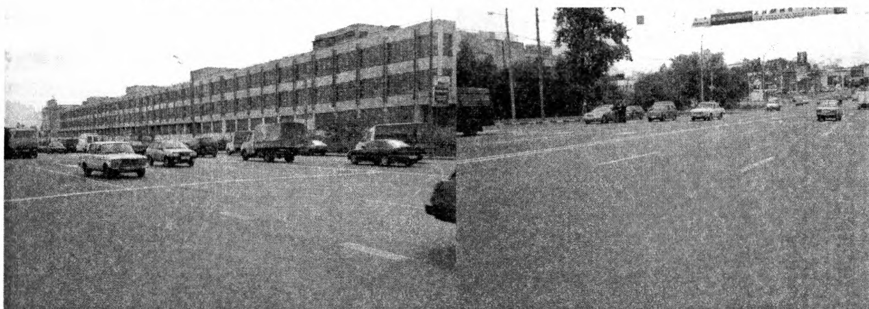
Рис. 2. Вид покрытия на выезде из Москвы по Волоколамскому шоссе (пост ГАИ) через год после ремонта с применением асфальтобетона ЩМА-15 на БИТРЭК.
