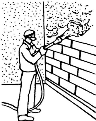
Рисунок 5 – Последовательное нанесение слоев обрызга, грунта
