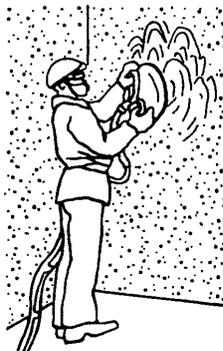
**Рисунок 8 – Механизированная затирка поверхности**
