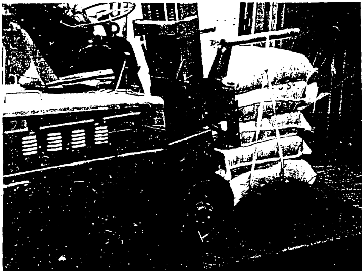
Рис.602.СК. I. Погрузка в контейнер грузов в мешках пакетами в одноразовых пакетирующих стропях. Порт Ленинград.
