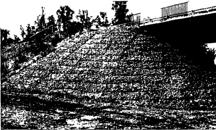
*Рис. 29. Укрепление конуса путепровода матрасами «Рено» с подложкой из нетканого геосинтетического материала*
