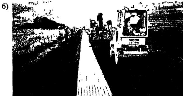
*Рис. 30. Армирование асфальтобетонных покрытий геосеткой:*
